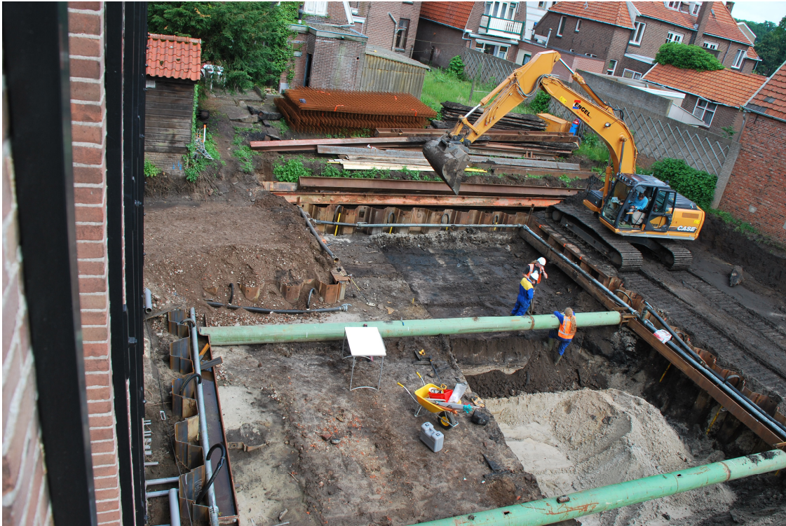
Afbeelding 5.1 Overzicht van de opgraving binnen de metalen damwanden, gezien vanuit pakhuis De Vlijt, zichtbaar zijn de damwanden en stempels (foto Grontmij).
